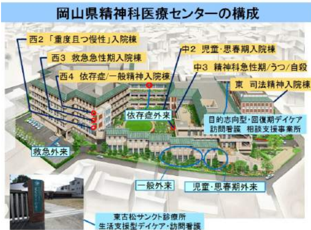
図：岡山県精神科医療センター外観
